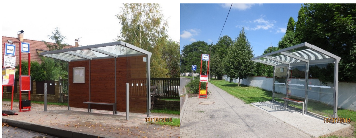
Fotodokumentace – Rekonstrukce a výstavba zastávek - 2014
